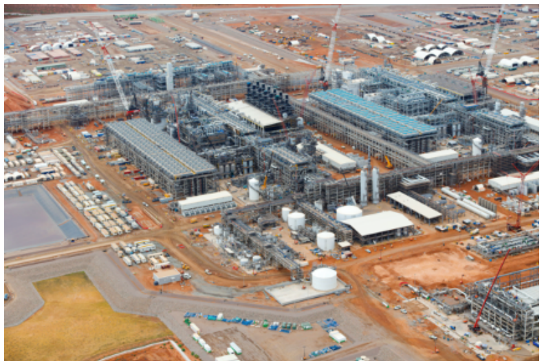
Wheatstone LNG Plant
